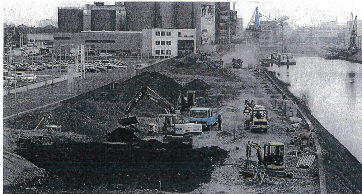
Die Erdarbeiten für den im Schnitt nur 30 Meter breiten, aber 850 Meter langen Uferpark auf der Hafemole I sind im vollen Gange. Ende Mai soll die neue innerstädtische Grünanlage mit Spielplätzen und Liegewiesen fertig sein. NGZ-FOTOS (4): WOI
